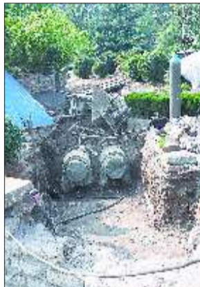
主管道已经用到了河堤上,过河后,才能实现管网贯通。本报记者 赵丽 摄
