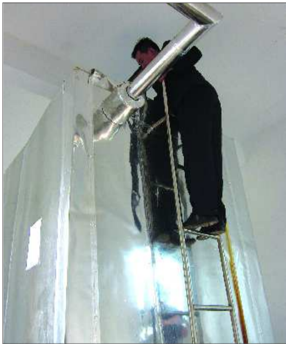
物业人员经常对高压水箱进行检查。
