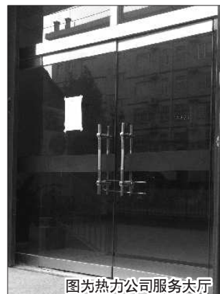
图为热力公司服务大厅
