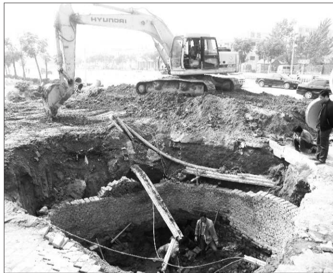
▲牡丹路与中华路交汇处,工作人员正加紧展开顶管作业施工。本报记者 景佳 摄
