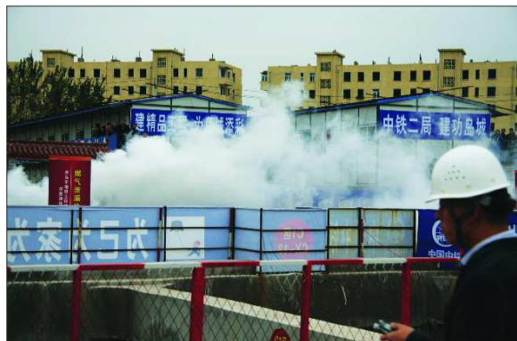
▲燃气公司工作人员对燃气管线进行“抢修”。
