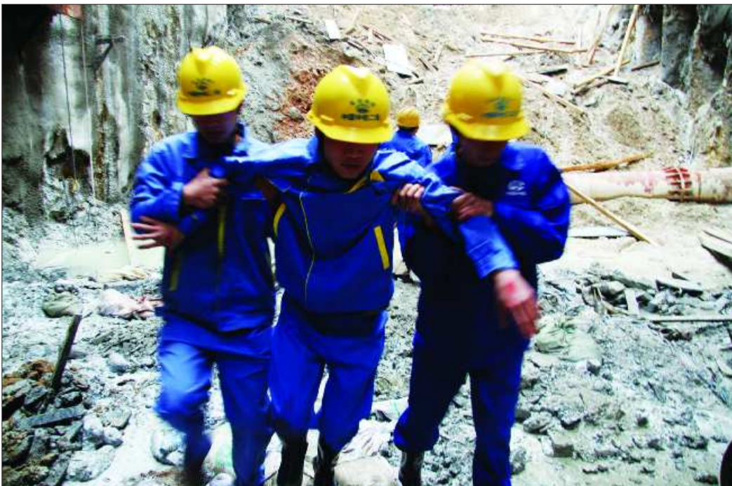
▲施工人员抢救“受伤的工友”。
