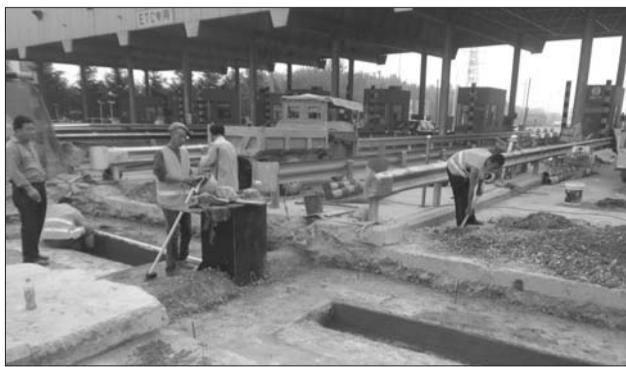
沈海高速部分路段正在对车道进行破碎。
