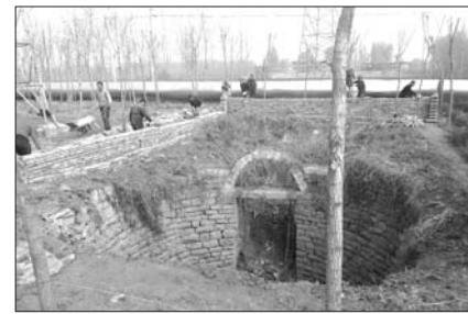
石横镇大口井防护设施建设现场。
