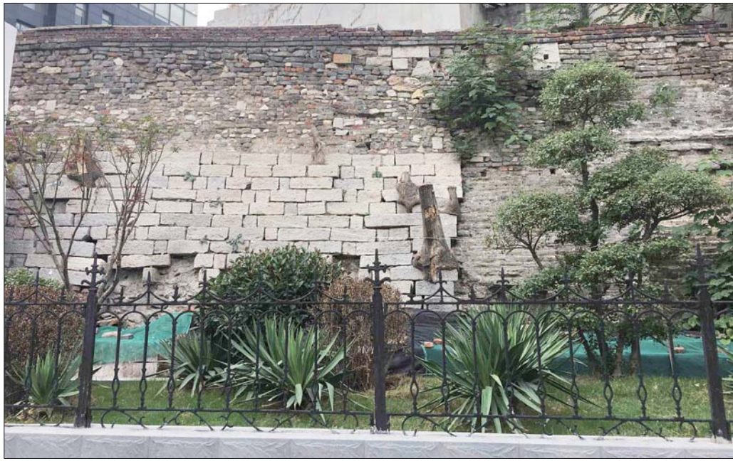
城墙遗址周围已经用绿化带隔离了起来。 见习记者 张晓燕 摄
