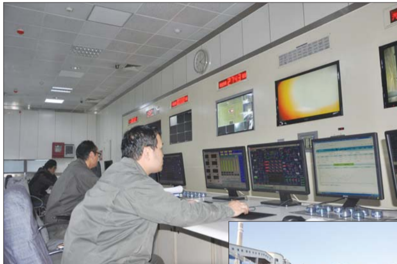
▲ 供热管网已经完成升压试运营。
