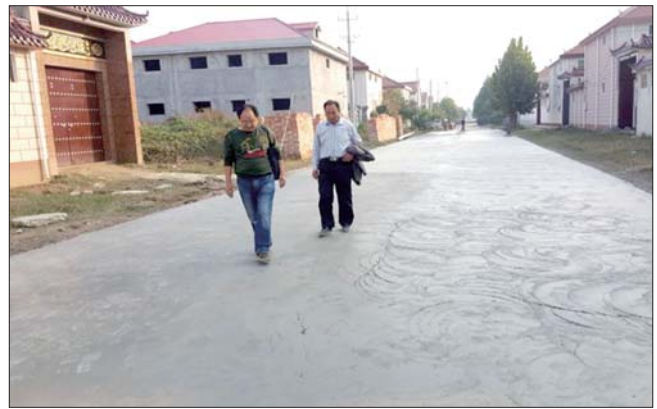
第一书记为民修路,始终与村两委一起,战斗在路基工程一线。
