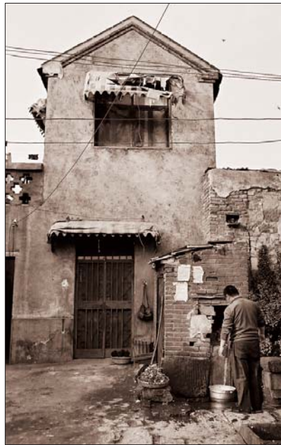
趵突泉自来水水井及蓄水池。
