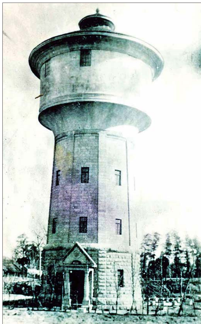
解放前位于经七纬二的水塔
