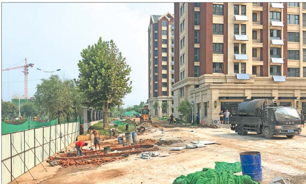
虽然交房时间已过了一个多月,但基础设施建设仍未完工,小区内工人们紧张地忙碌着。
