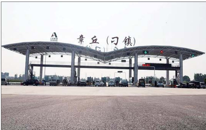
章丘交通对外联系沟通的北大门——青银高速济青线章丘(刁镇)收费站。 本报记者 支倩倩 摄
