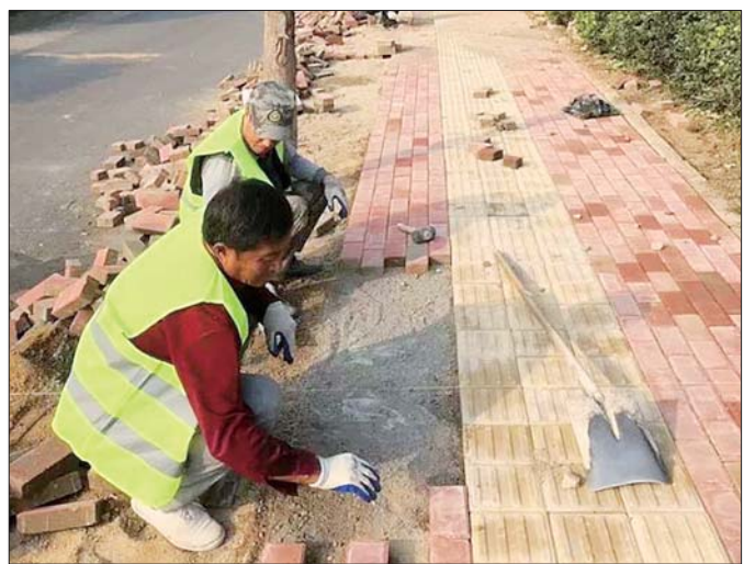
工人在铺设人行道花砖。 本报记者 支倩倩 摄
