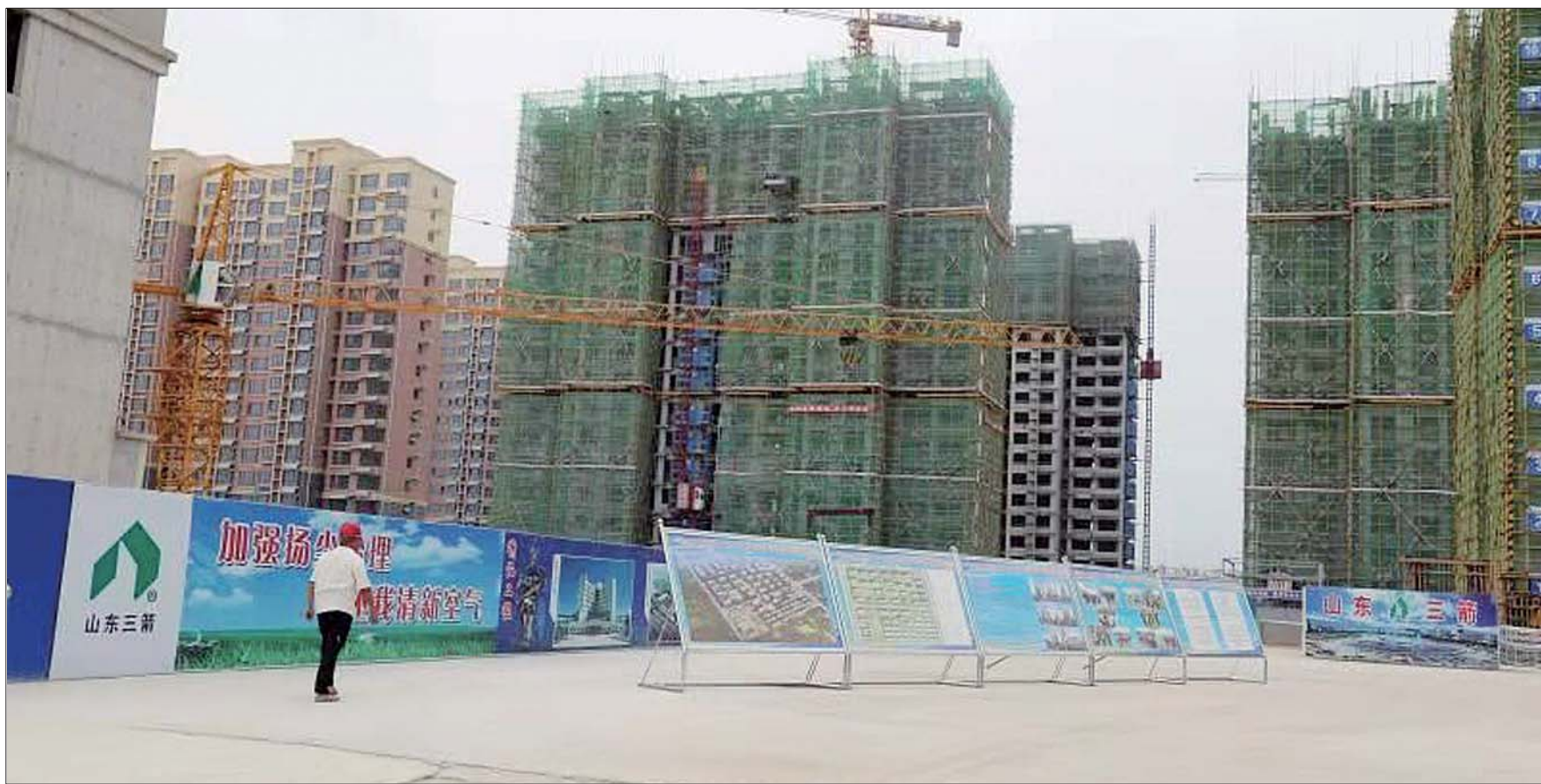
如火如荼的管家社区(二期)建设现场。
