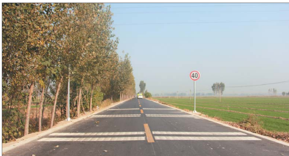
竣工通车的新耿路。
