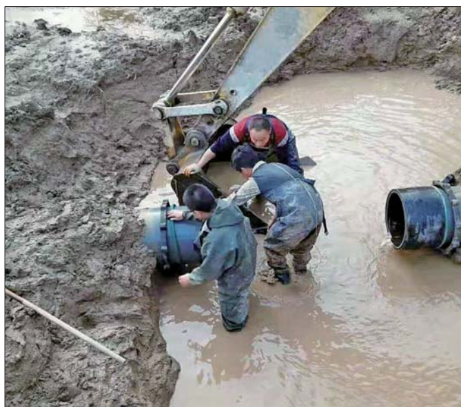
10月13日太平水厂抢修供水管道现场。
