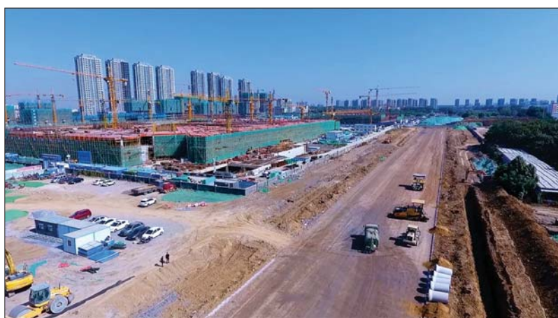
香江路施工进度航拍图。
