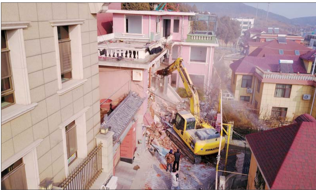
▲10日,金鸡岭片区一座占地1000余平方米、建筑面积600余平方米的违建别墅被拆除。本报记者周青先 摄
