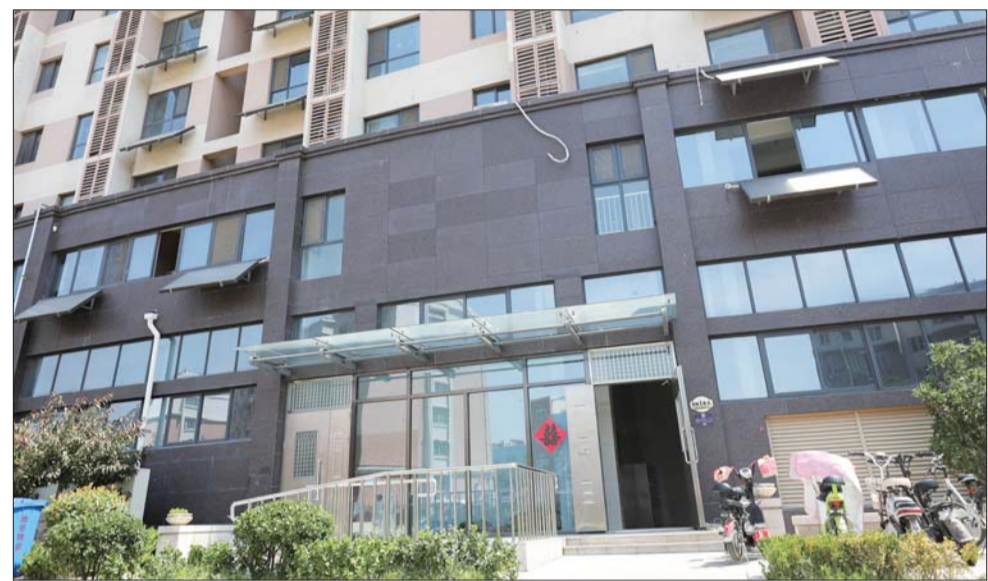
电梯出现故障的翠都国际二期6号楼1单元。齐鲁晚报·齐鲁壹点见习记者 房体朔 摄
