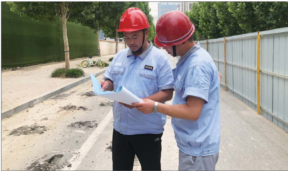
清洁取暖工程杨桥街段开始施工。
