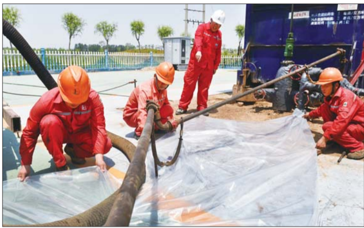
施工前铺设防渗膜,防止油污落地。
