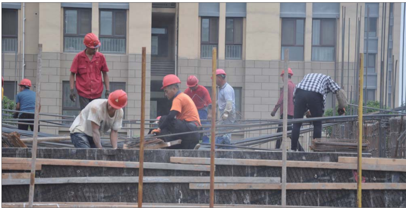
项目一期为民服务中心工程正在施工。
