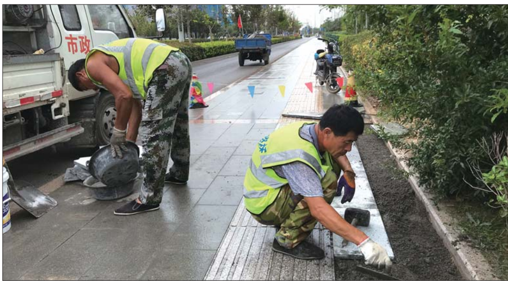
工人正在修补人行道上的地砖。
