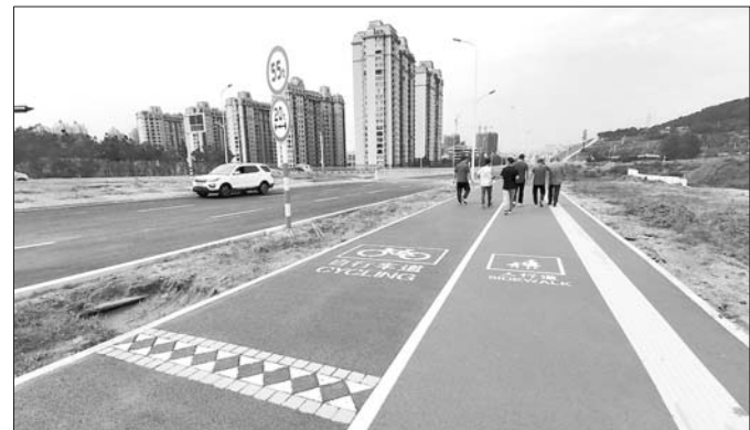
贴心又人性化的分离式设计将人行道、自行车道与机动车道分离。齐鲁晚报·齐鲁壹点记者 曲彦霖 摄
