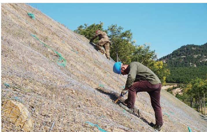
施工人员正在山体进行喷播锚杆施工。
