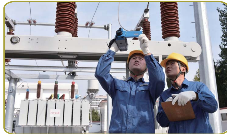
工作人员手持红外热成像仪进行设备测温。
