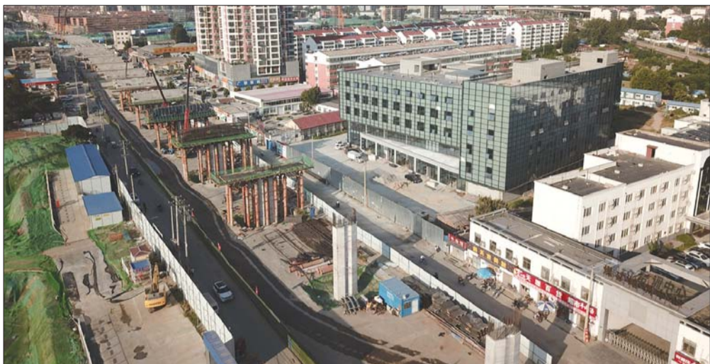
王母阁路跨线桥工程航拍图。
