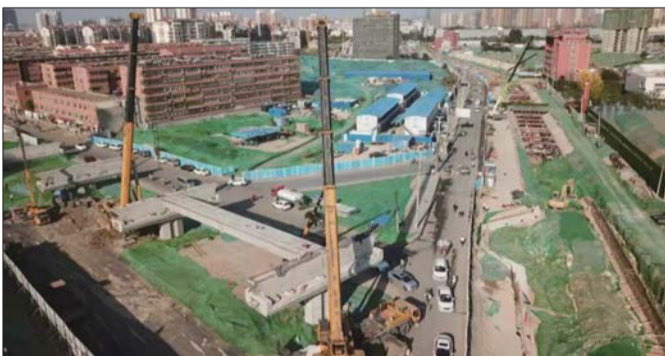
王母阁路跨线桥正在进行箱梁架设。
