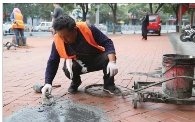
施工人员正在对井盖周边进行平整。齐鲁晚报·齐鲁壹点见习记者 房体朔 摄
