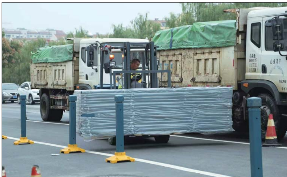
运河路和健康路交叉口正在安装隔离护栏。齐鲁晚报·齐鲁壹点见习记者 房体朔 摄
