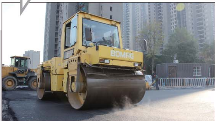
压路机正在压实路面。本报记者王博文摄
