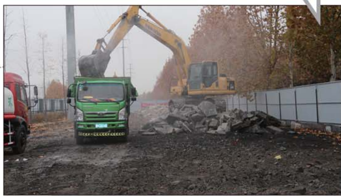
和济北路拓宽工程施工现场。本报记者邓超摄
