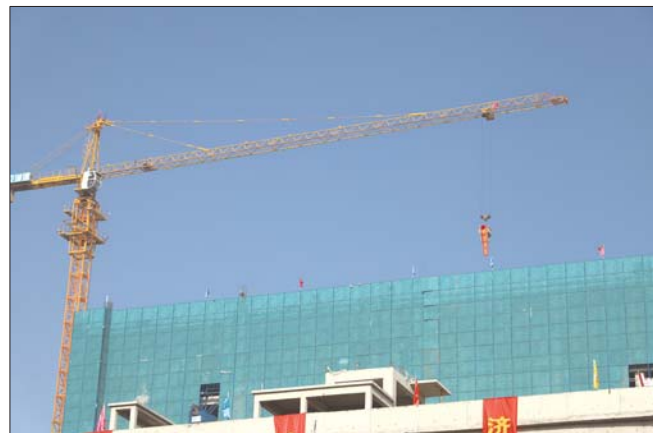
市立医院项目封顶。
