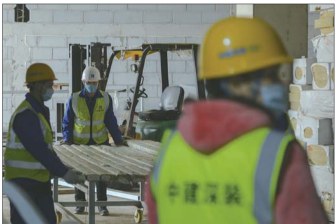
加工车间,工人切割、组装幕墙的构件。
