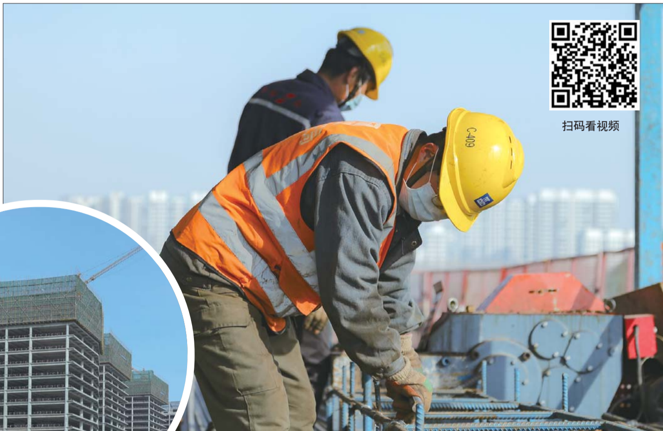
在济宁市文化中心三期项目施工现场,工人戴着口罩施工。
