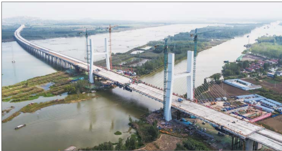
俯瞰枣菏高速微山湖特大桥。齐鲁晚报·齐鲁壹点记者 李岩松 摄
