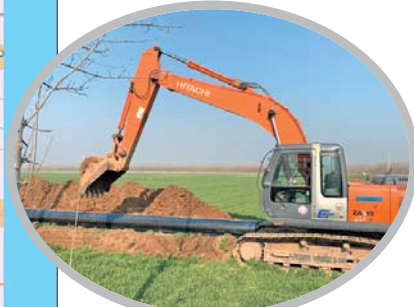
◀工程示意图 ▲施工现场
