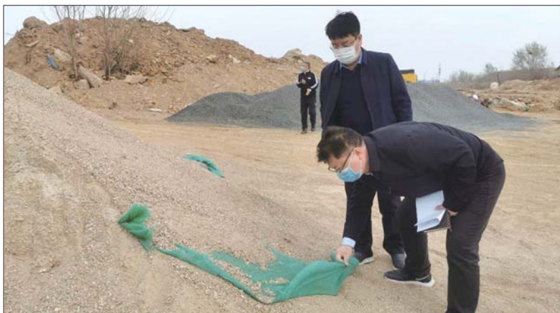
执法人员检查小官庄村渣土覆盖问题。
