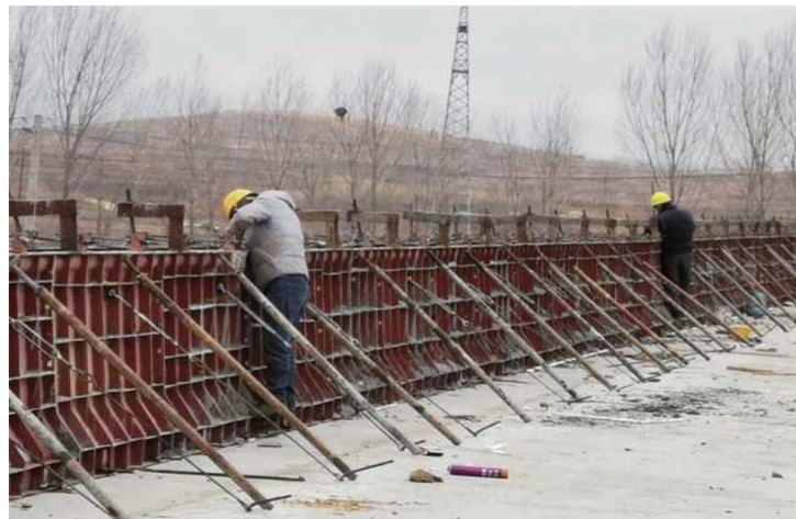
文莱高速乳山段施工现场。
