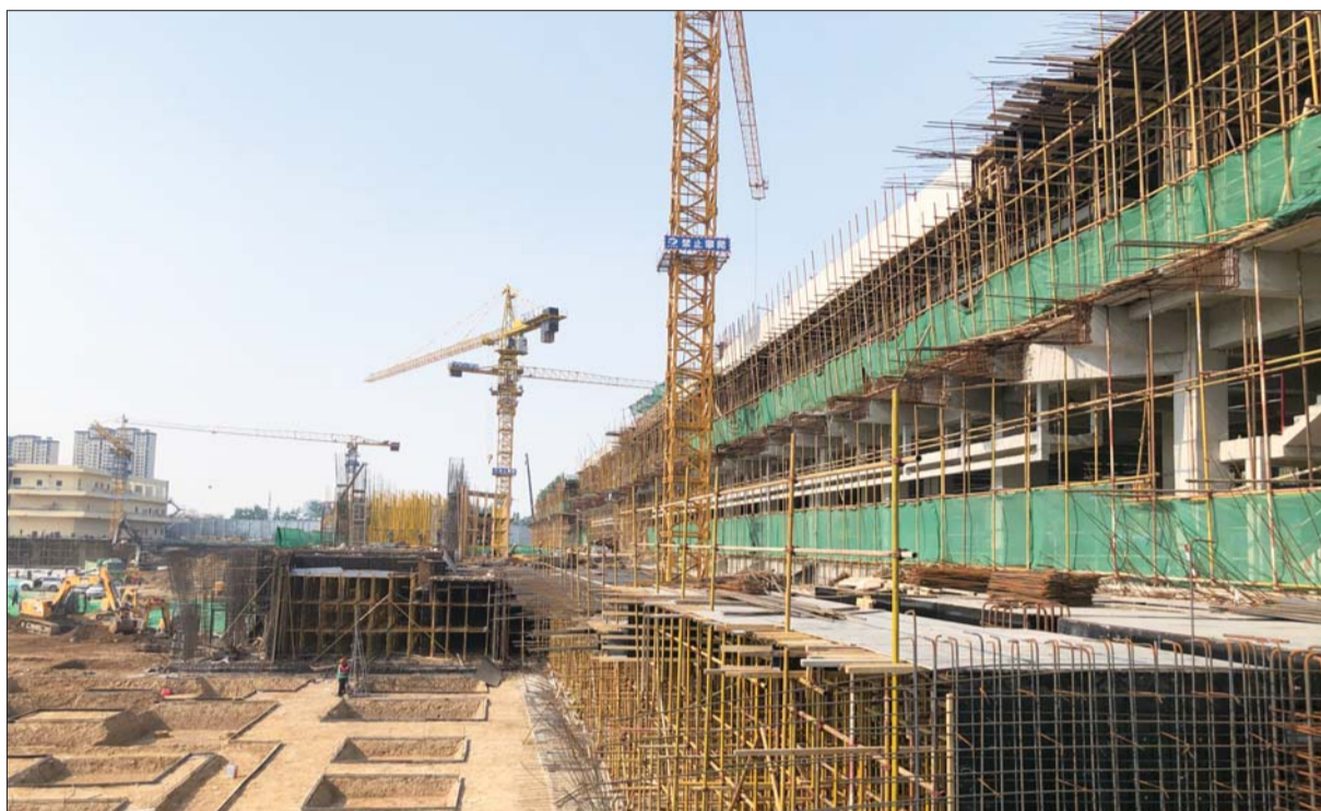
商业金街已经基本完成3层主体建设。
