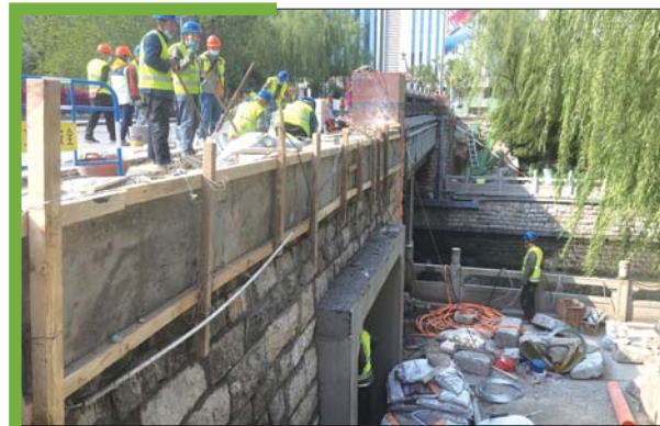
南门桥下新增箱涵,建好后游客直接从箱涵通过桥底,不用再绕行桥面。
