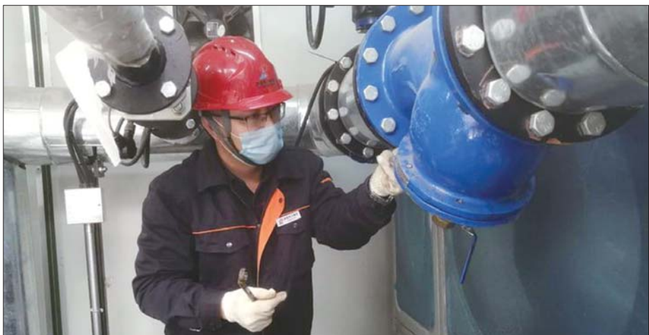
五一期间,一线热力职工坚守岗位发光发热。
