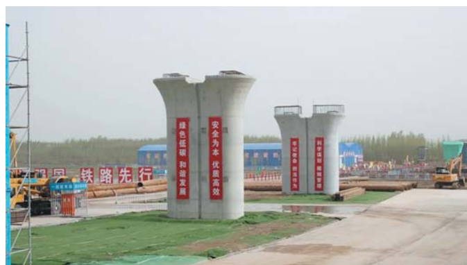
徒骇河特大桥项目施工现场。
