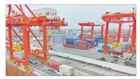
需在远控室动动手柄就可以完成集装箱的装卸作业,极大降低了劳动强度,使港口综合效率提升了31%。
