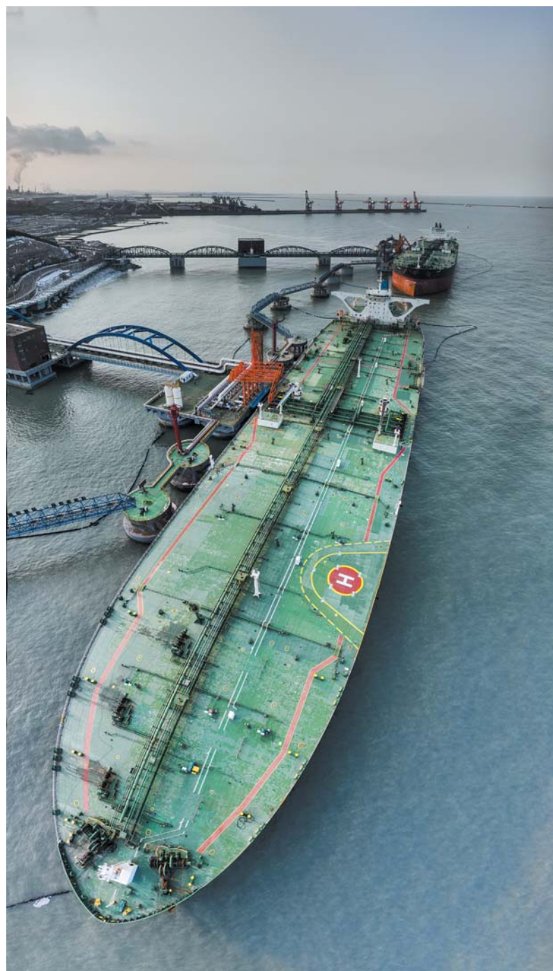
山东港口烟台港是全国唯一码头、罐区、管道一体化运营的港口。
