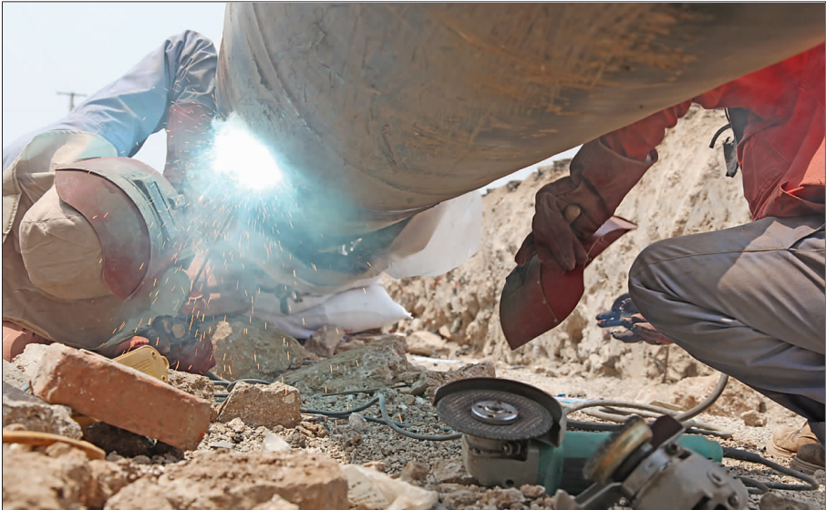
燃气部门正在对省城燃气管线实施改造。 戚淑军 宋立军 摄
