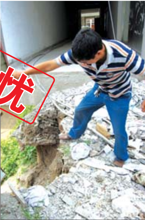
一脚踩上去,地基坑边缘的泥土就会往里塌陷。 本报记者 孙国祥 摄
