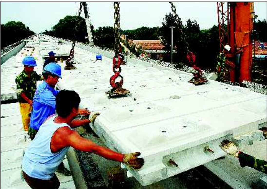
2日,京沪高铁工程部门正在对德州至北京段铺设博格板。 本报见习记者 马志勇 摄
