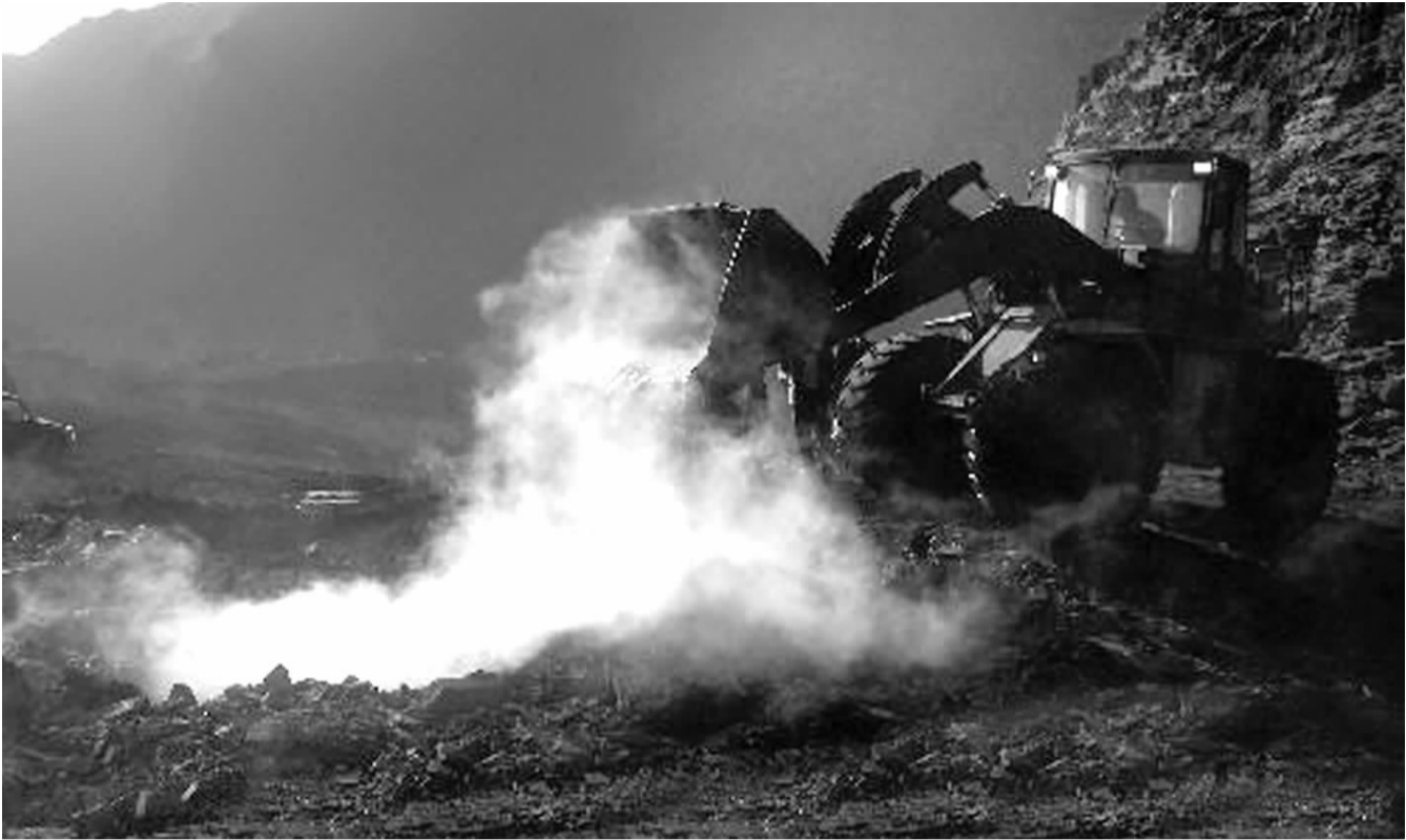
内蒙古乌海一处煤田火区,施工人员在剥离燃烧过的煤层。
