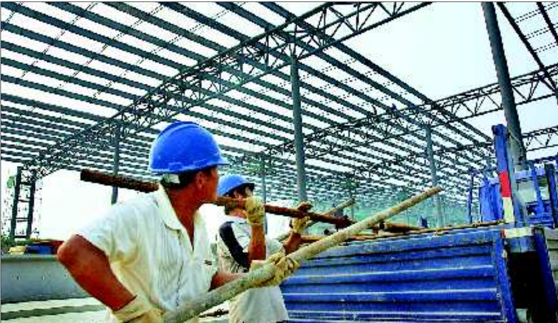
右图:13日,无站台柱雨棚主桁架已经架设完成。 本报见习记者 马志勇 摄
