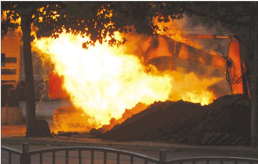
▲18日,在聊城一施工工地,挖掘机把地下天然气管道挖断,爆炸后引起大火。
