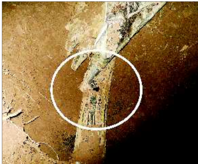
施工用的挖掘机将直径200毫米的中压燃气管道挖断,造成大量天然气泄漏。
